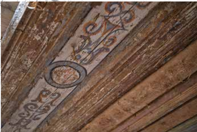
Teile der Balken-Bohlen-Decke von 1573/74 Foto: Tim Birkner
