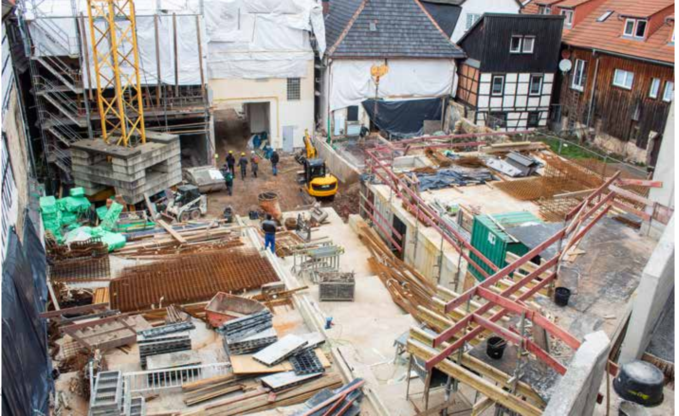
Der Blick vom Stadtschloss ermöglicht die Sicht auf Stahl, Beton und Fleiß.
