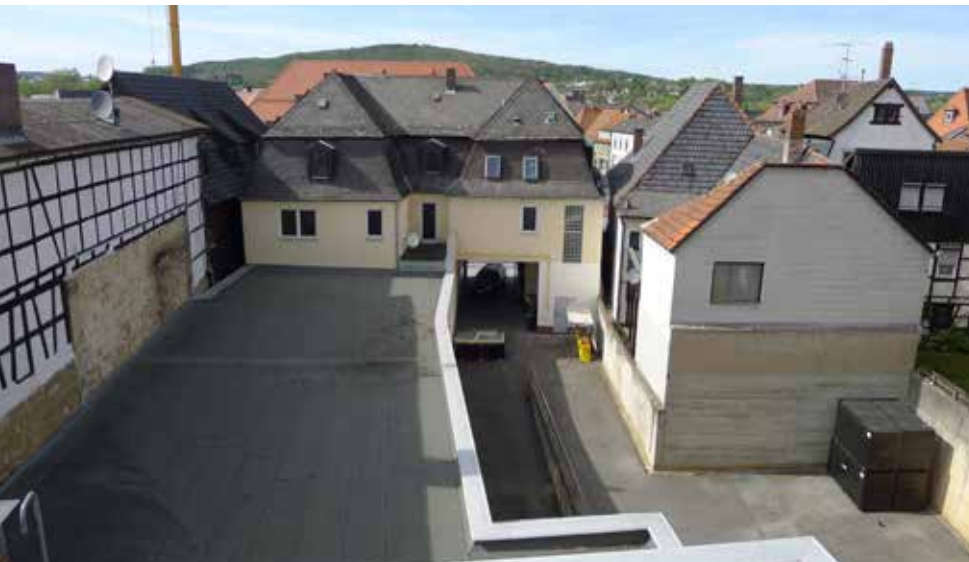
Südansicht des Gebäudes Marktplatz 10 mit Anbau und Grundstück
